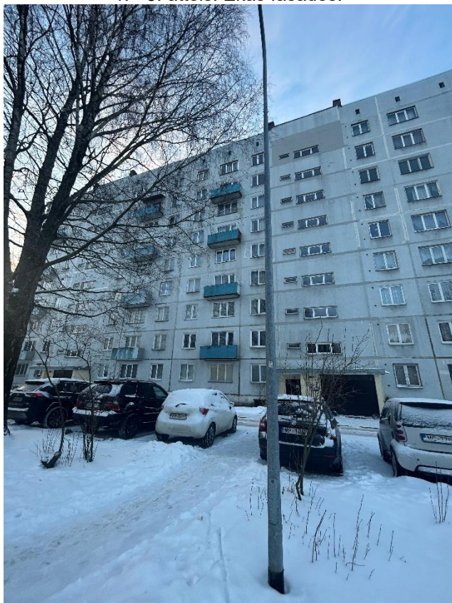
1. - 3. attēls. Ēkas fasādes.
